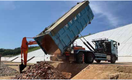
災害廃棄物受入れの様子
