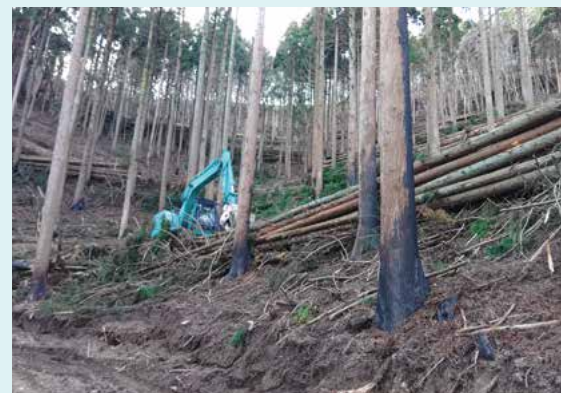
被災森林での伐採現場
