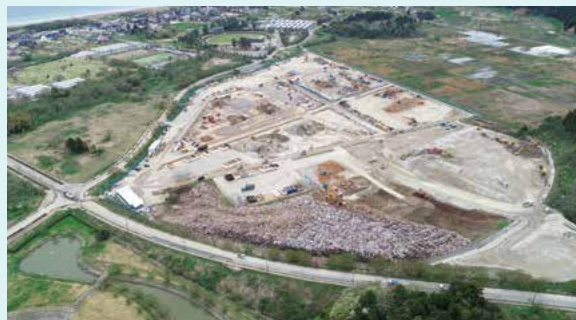
2025年4月下旬 仮置場 運営時
